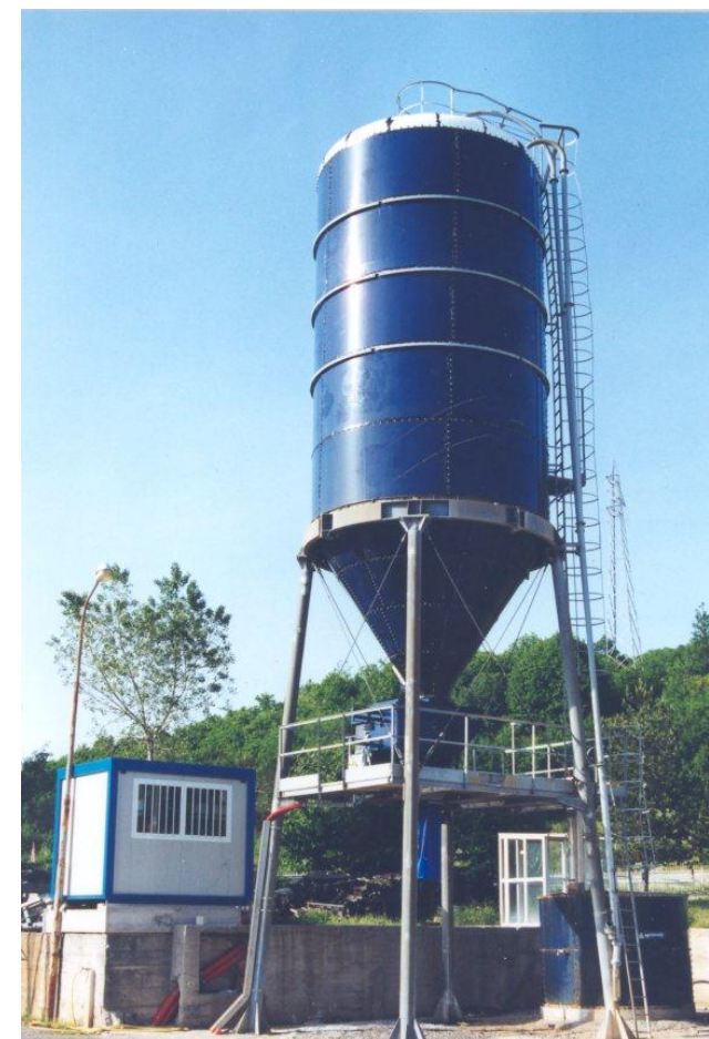
Silos di stoccaggio
